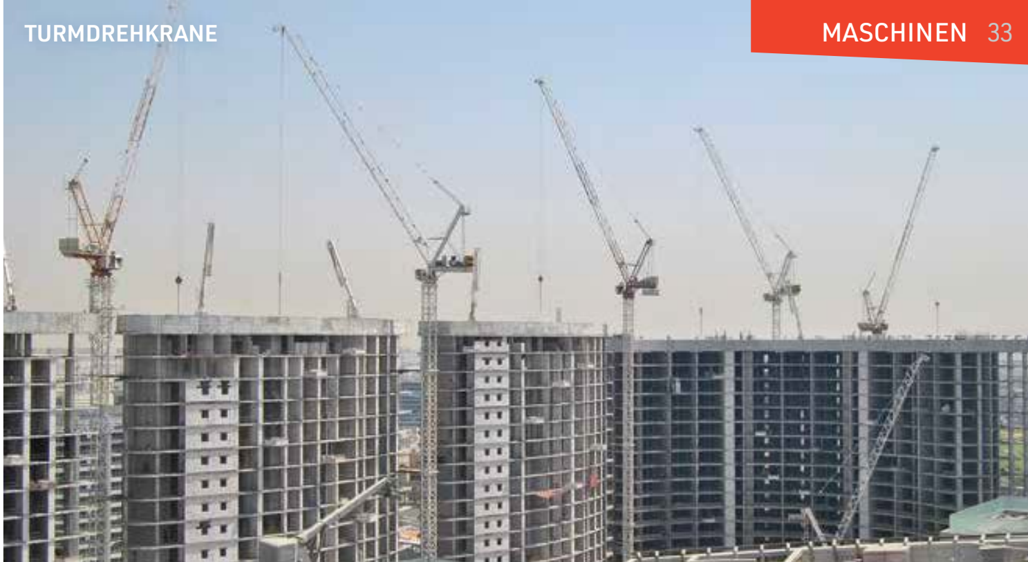
Massiv: 14 CTL140-10 und CTL260-18 von Terex errichten Neubauviertel „Jewel of the Creek“ in Dubai
